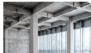
Estruturas de betão
