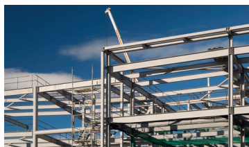
Estruturas de aço
