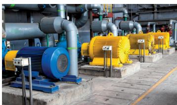
Installazione di apparecchiature / Impianti
