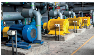
Installazione di apparecchiature / Impianti
