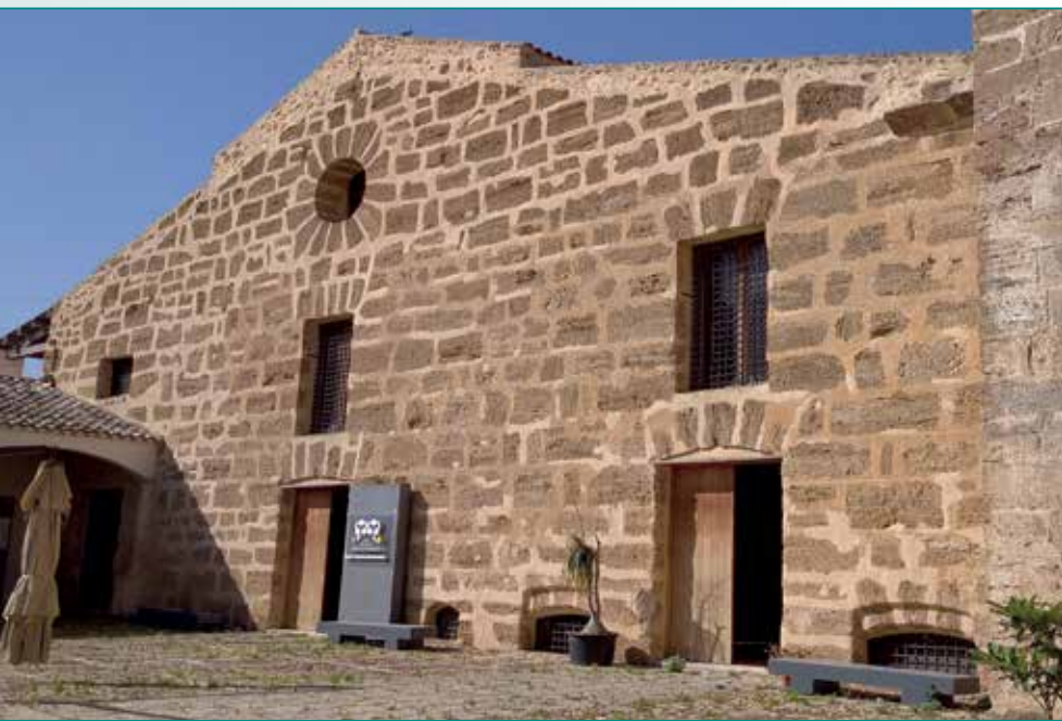
Fig. 1 - Facciata principale della "Real Cantina Borbonica".
